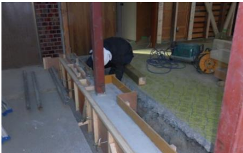
平成26年・自治会館耐震化工事
