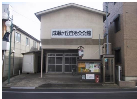
平成26年 改修前の自治会館
