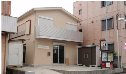
耐震化後の自治会館
