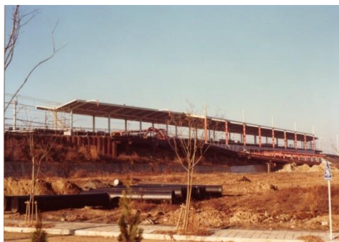
昭和53年 建設中の成瀬駅
