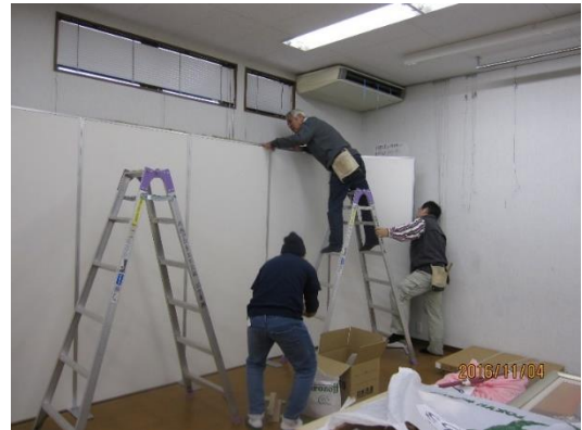
パネルの設置風景
