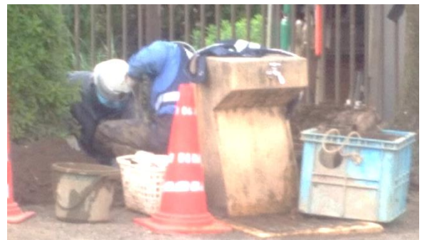
1丁目児童公園水道管漏水工事の様子
