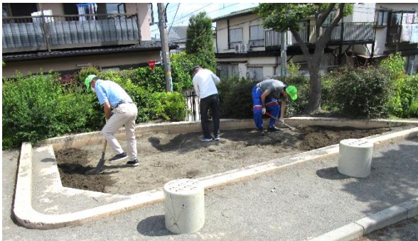
3丁目公園清掃の様子(砂場の掘り返し)
