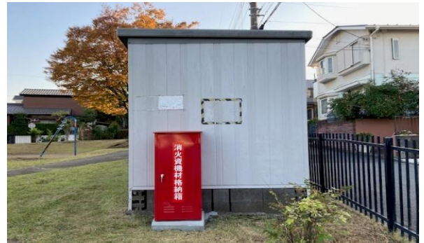
スタンドパイプ格納箱の様子
